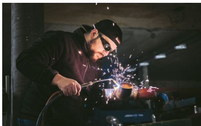
Arbeiten an der Heizung: Im Vogelsang sorgen im Winter 41 Erdsonden für Wärme. Im Sommer kann mit dem gleichen System sogar ein bisschen gekühlt werden. Die Photovoltaikanlage erzeugt einen Teil des Stroms für die sechs Wärmepumpen.
