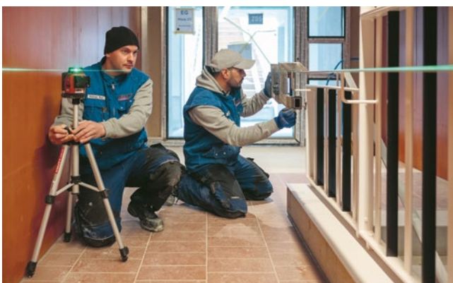
Massarbeit bei der Geländermontage. Die letzten Details der Gestaltung, wie zum Beispiel die Farbgebung der Treppenhauswände, waren in den letzten vier Baukommissionssitzungen 2021 festgelegt worden.
