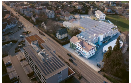
Auf dem Regi-Areal stehen heute verschiedene Wohn- und Gewerbebauten. Ein Teil davon soll nach Möglichkeit erhalten werden.
