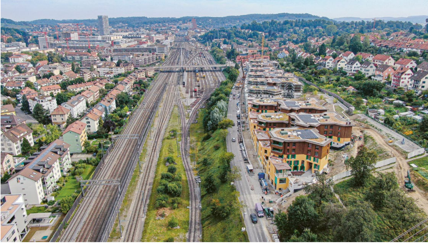
Bild vom September 2021: Kurz danach wurden die ersten Wohnungen bezogen – aufgrund des Verzugs einer Firma später als geplant.
