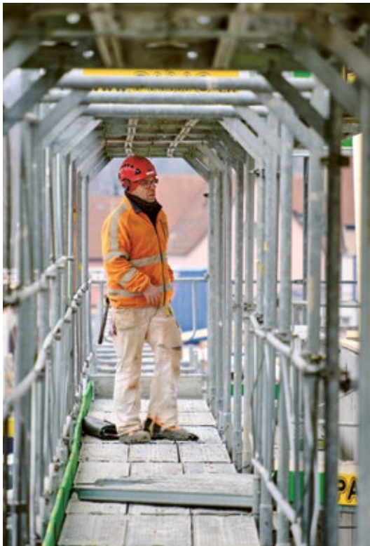
Auf dem Höhepunkt der Bauarbeiten arbeiteten täglich rund 120 Bauleute auf der Baustelle im Vogelsang. Hier Polier Patrick Mathys auf einem der vielen Baugerüste.
