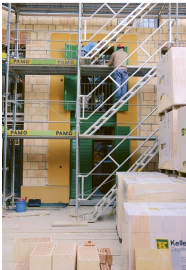
Das Fassadenmodell auf der Baustelle half zum Beispiel, die Funktion der Fensterläden zu überprüfen und zu optimieren. Bei etwa 1000 Fenstern in der ganzen Siedlung lohnt sich das.
