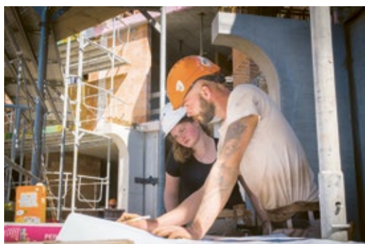
Lernende Zeichnerinnen und Zeichner EFZ mit Fachrichtung Architektur absolvierten im August und September während sechs Wochen auf der Vogel-sang-Baustelle ihr Baustellenpraktikum.
