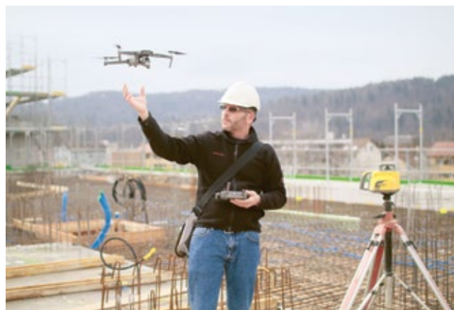
Um den Baufortschritt zu dokumentieren, setzt Bauleiter Christian Allenbach eine Drohne ein. Dabei entstehen auch beeindruckende Panorama-Bilder von der Baustelle.
