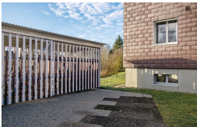
Velohäuschen an der Schottikerstrasse in Elsau: Das gleiche Modell kam bereits in einigen anderen Siedlungen zum Einsatz. Die Holzplatten können in verschiedenen Farben gestrichen und so an die Erscheinung der Häuser angepasst werden.
