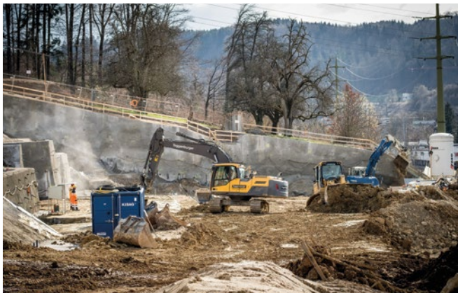
Für die Baugrube wurden 80 000 Kubikmeter Aushub in hunderten Lastwagenfahrten abgeführt. Damit der Hang stabil bleibt, befestigten die Bauleute die Baugrube mit sogenannten Nagelwänden.
