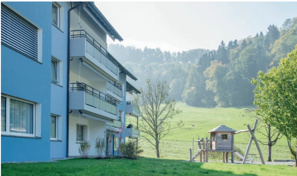
Die GWG hat drei Siedlungen mit insgesamt 70 Wohnungen im Tösstal. Das ist die erneuerte Fassade an der St. Gallerstrasse in Turbenthal.
