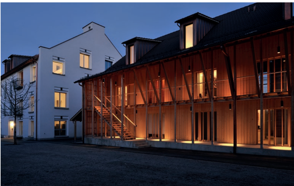
Orenberg: 1 Gemeinschaftsstube, 61 Wohnungen, davon 7 mit 2.5 Zimmern, 22 mit 3.5 Zimmern, 25 mit 4.5 Zimmern, 1 mit 5.5 Zimmern, 6 Reiheneinfamilienhäuser mit 5.5-Zimmern; Architektur: BDE Architekten; Bezugstermine: seit Dezember 2017 in Etappen.
