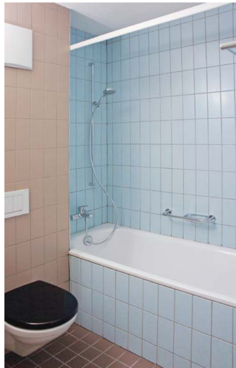
Blick in ein Badezimmer, nach der Sanierung.
