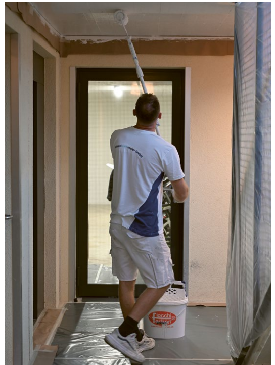
EINEN NEUEN ANSTRICH ERHALTEN die Wände und Decken im Keller.
