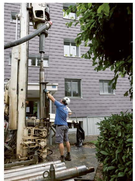
NACHHALTIGE WÄRME AUS DEM ERDREICH: Pro Haus wurden zwei Sonden für die neue Heizung gebohrt.
