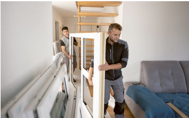
DA IST EIN NEUER FENSTERRAHMEN auf dem Weg. Bald schon ist diese Wohnung besser isoliert als vorher. Fotos: MF
