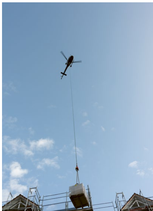
SPEKTAKULÄRE ANLIEFERUNG DER SOLAR-PANELS mit dem Helikopter, weil der Platz für einen Kran-LKW nicht reichte. Foto: GWG
