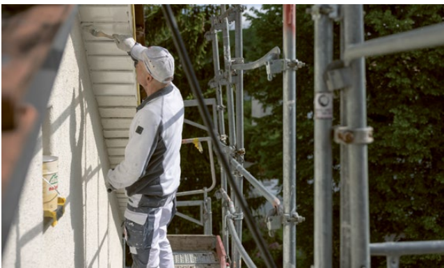
Streichen der Dachuntersicht. Foto: MF
