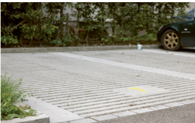
Das Wasser versickert im Rasengitter und kann von den Pflanzen aufgenommen werden.
