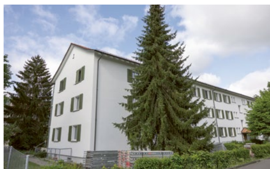
An der Flüeli-/Bürglistrasse wurden die Fassaden geflickt, gewaschen und gestrichen.
