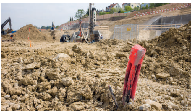
Das obere Ende einer der zukünftig rund 40 Erdwärmesonden im Vogelsang. In einer Wärmepumpe wird die Energie in ein höheres Temperaturniveau umgewandelt und danach den Heizungen zugeführt.
