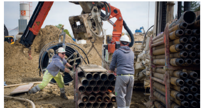
Bis etwa 250 Meter wird in den Boden gebohrt. Dafür braucht es viele Meter an Bohrgestängen. Im Hintergrund befindet sich die noch aufgerollte Erdsonde.
