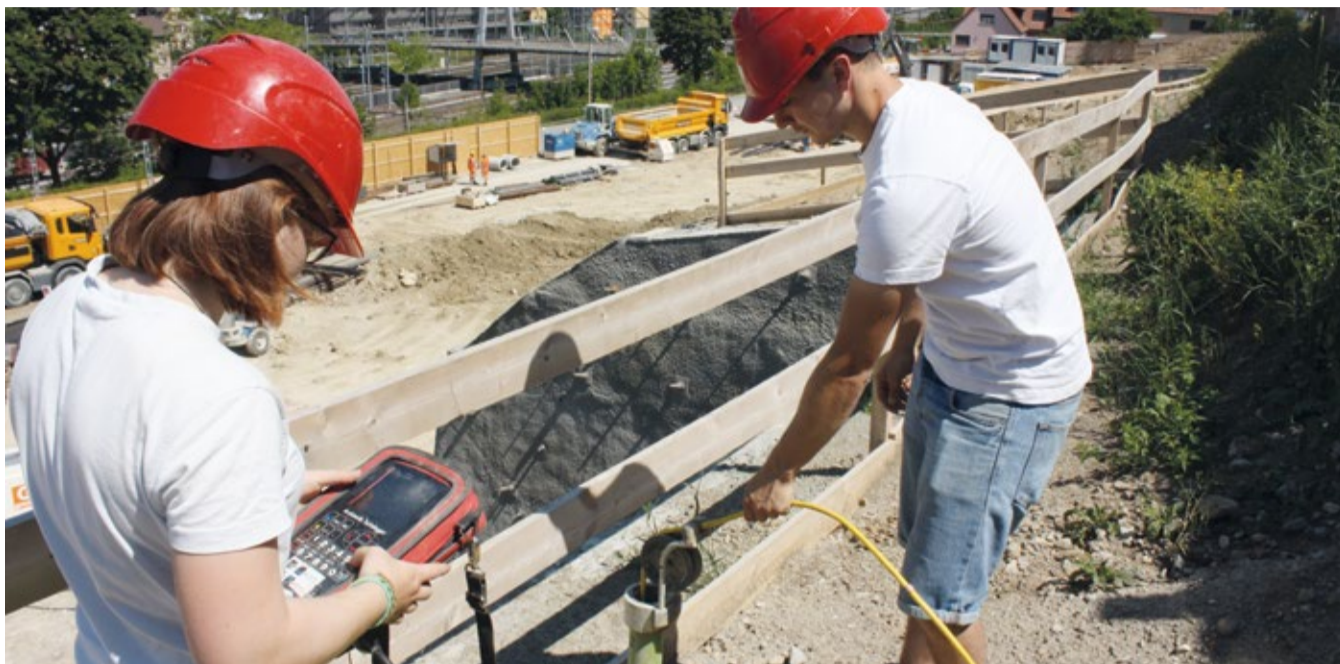
Laura Schenk und Benjamin Moos messen mit dem Inklinometer, ob sich der Untergrund oberhalb der Baugrube verschiebt. Fotos: LZ
