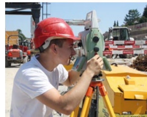
Benjamin Moos stellt mit dem Tachymeter sicher, dass sich die Häuser in der Umgebung nicht bewegen. Im Blickfeld: Gelbe Messpunkte, die an den Häusern befestigt sind.
