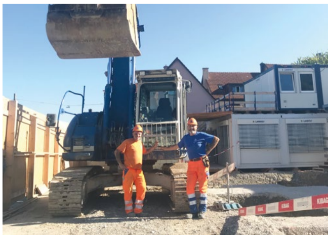
Freitag, 13. September: Der viel besagte «Unglücksfreitag» wurde für diese Bauleute zum Glückstag. Dann nämlich haben sie den Aushub erfolgreich abgeschlossen – und wurde der letzte Bagger abgeholt. Foto: MS
