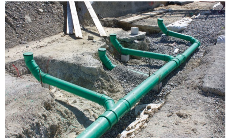
Verstopfung? Nein danke: die Abwasserrohre liegen dank der weissen Steine in einem leichten, genau berechneten Neigungswinkel. So kann alles gut abfließen.
