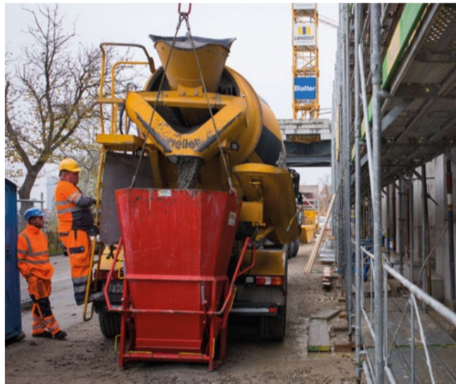
Jede Minute zählt: Der frische Beton wird vom Laster aus direkt in den Kübel geschüttet und muss sofort verarbeitet werden. Fotos: PB
