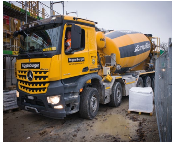
Sobald ein LKW mit Betonmischer entleert ist, steht schon der nächste bereit.
