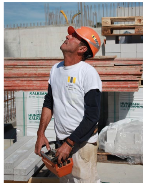
Wer hat als Kind nicht davon geträumt, einmal einen grossen Kran zu fahren? Giampaolo De Lorenzis hat den Traum zum Beruf gemacht. Per Funk steuert er tonnenschwere Lasten – hier vom Boden aus. Fotos: LZ
