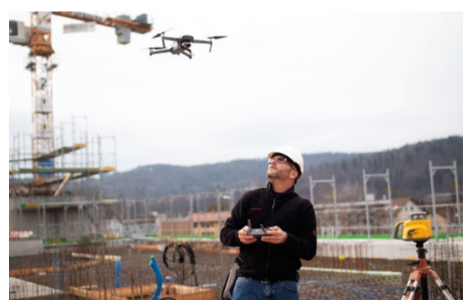
Bauleiter Christian Allenbach setzt eine Drohne ein, um die verschiedenen haustechnischen Einlagen in den Betondecken genau zu dokumentieren. Foto: SB
