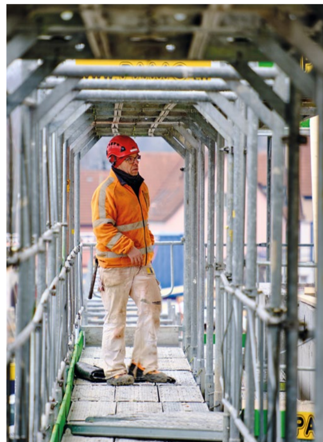
Der Polier Patrick Mathys während der Arbeit auf dem Gerüst.
