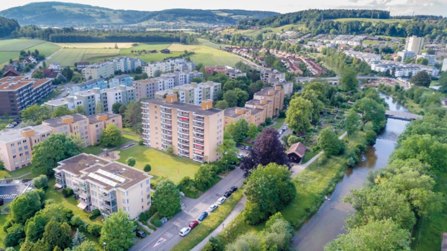
DIE SIEDLUNG NIEDERFELD liegt inmitten von Grün und gleich an der Töss. Diesen Sommer wird die Umgebung aufgewertet. Neu wird es auch einen Siedlungsraum und eine Recyclingstation geben. Fotos: ADB
