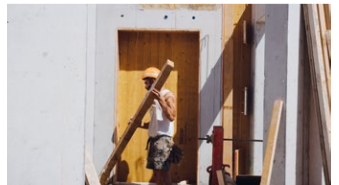
Eine vorgesehene Aussparung in einer Stahlbetonwand – hier z.B. eine Türe – wird durch den Architekten geplant und durch den Maurer massgenau mit einer Holzschalung ausgespart.
