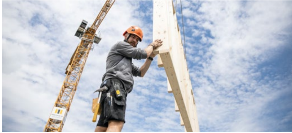
Dave Kuster, Projektleiter bei der Sprenger Söhne AG, packt auch vor Ort mit an. Hier manövriert er ein Holzelement, das der Kran behutsam in die Höhe gehievt hat, zum richtigen Ort. Bilder: MF
