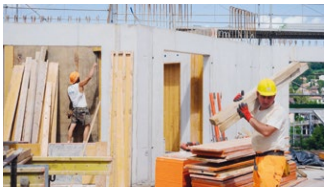
Viele Wände im Vogelsang werden betoniert. Nach dem Aushärten des Stahlbetons wird die Holzschalung entfernt und das fertiggestellte Betonbauteil kommt zum Vorschein. Dann stellt sich heraus, ob es den Anforderungen entspricht oder ob die Oberflächen nachbearbeitet werden müssen.
