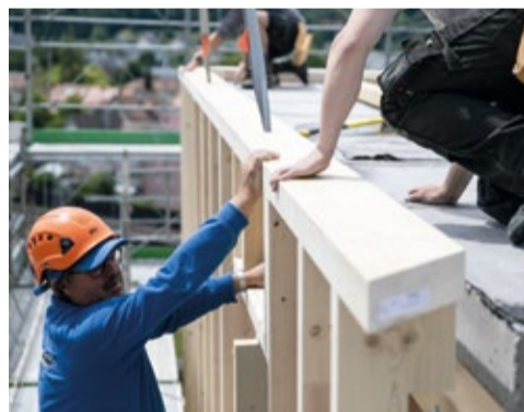
Es braucht mehrere Personen und Hände, um die rund 30 Quadratmeter grossen Holzelemente passgenau zu montieren.
