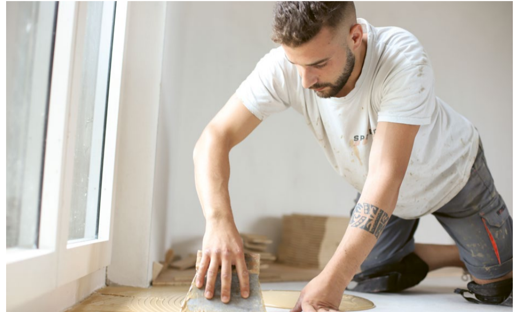
Der Monteur Diogo Santos beim Auftragen des Klebers. Der sogenannte «Zweikomponenten-Ecoleim» fixiert den Parkettboden – dazu muss er eben und lückenlos verteilt werden.
