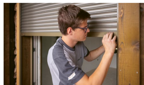
Noah Bellmont schraubt die Anschläge an die Endschiene, damit der Rollladen nicht in den Sturz reingezogen werden kann.
