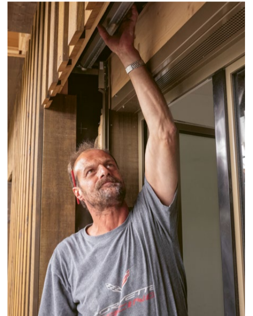
Rainer Bellmont testet, ob der montierte Rollladen auch schön in den Schienen gleitet.
