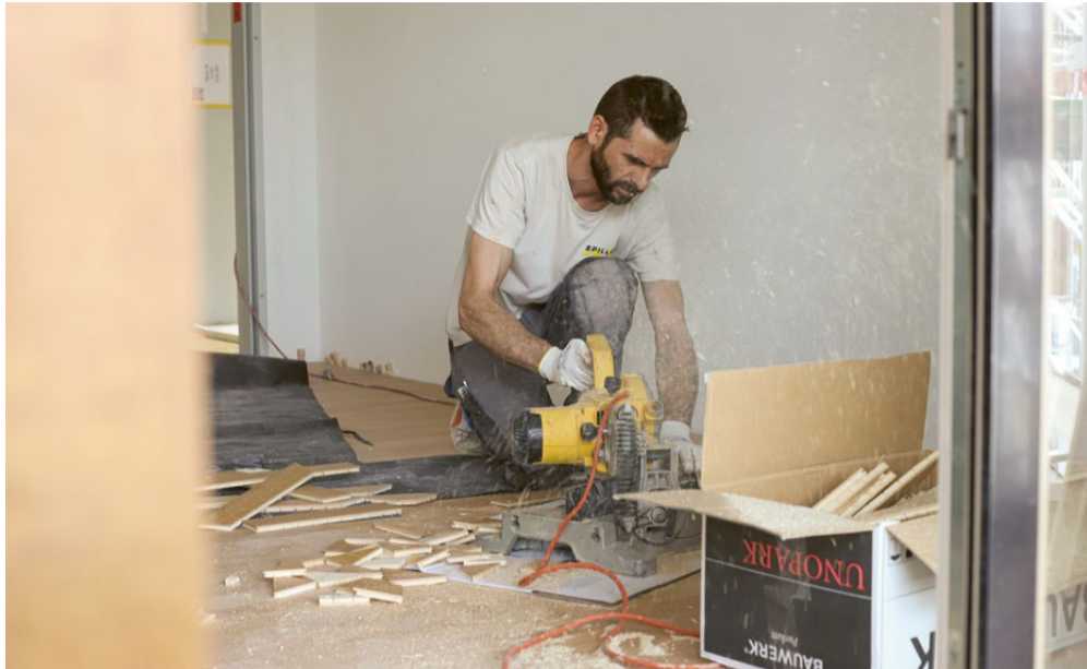
Mit dem «Schiffsboden» gibt es verhältnismässig wenig Schnitt-Abfälle. Zugeschnitten werden müssen einige Riemen aber dennoch – wie hier von Monteur Paulo Andrade. Bilder: NE
