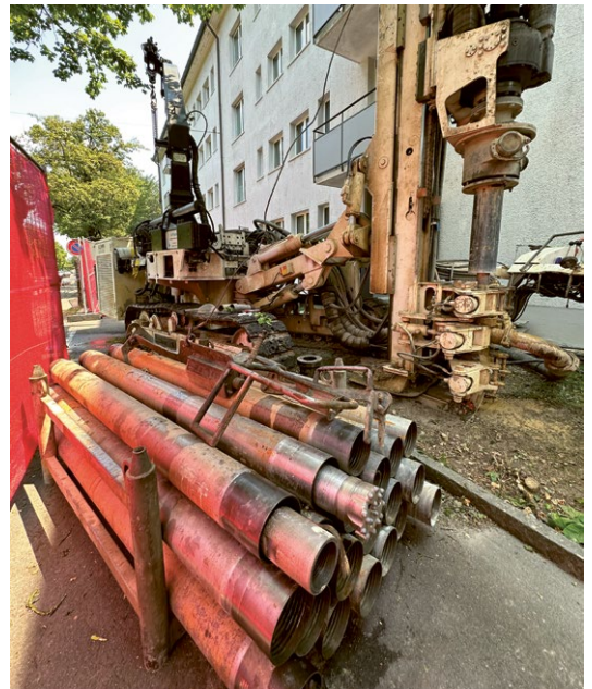
Auf dem schmalen Streifen zwischen dem Haus und der Frauenfelderstrasse wurden mit eindrucksvollen Bohrgeräten Löcher für die Erdsonden gebohrt, welche später die 16 Wohnungen mit Wärme versorgen.
